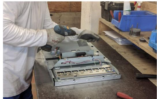
Manuelle Zerlegung eines PC-Monitors
