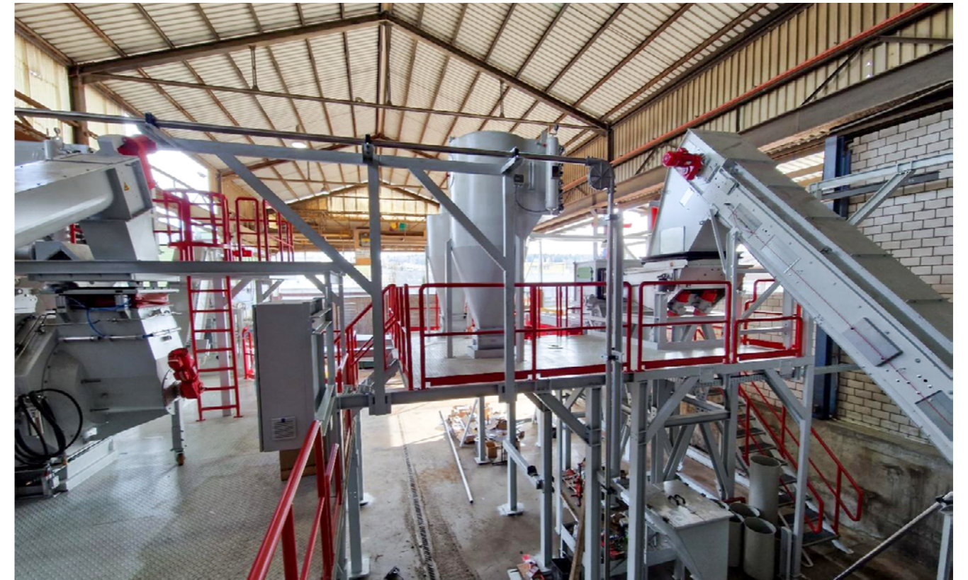
URT-Kühlgeräte-Recyclinganlage der E. Flückiger AG im Aufbau.
