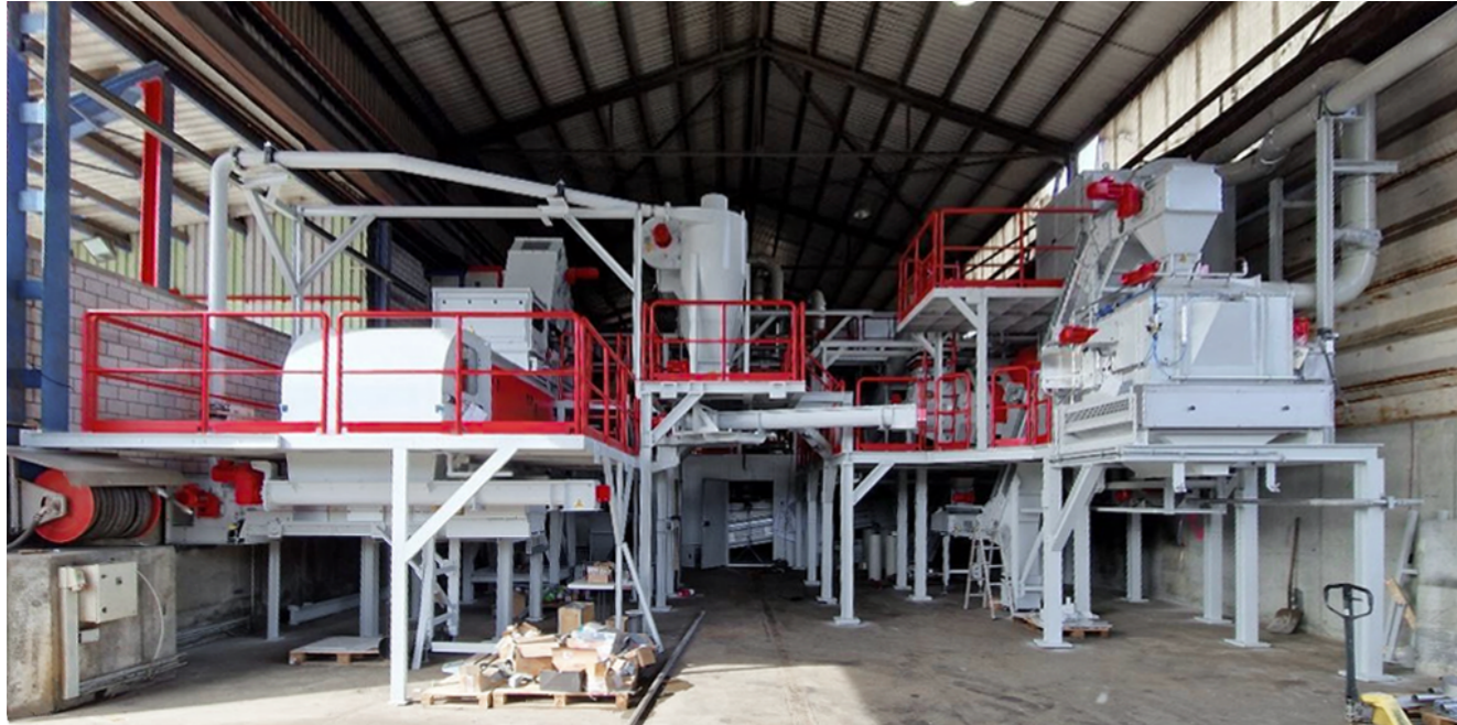
URT-Kühlgeräte-Recyclinganlage der E. Flückiger AG im Aufbau. Links: Wirbelstromabscheider, rechts: Pelletkühler.
